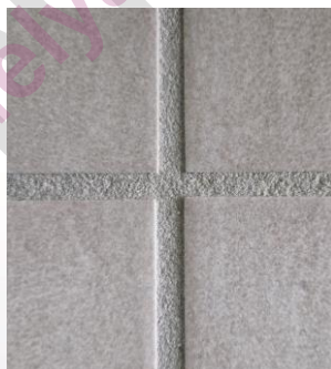
Joints après 15 minutes d'application d'ENZYROX dilué à 1%
